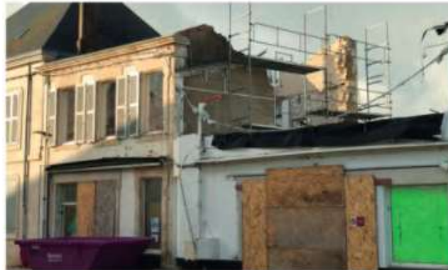
Le chantier de l'ancienne Maison de la Presse, à La Couarde. © C.B.
