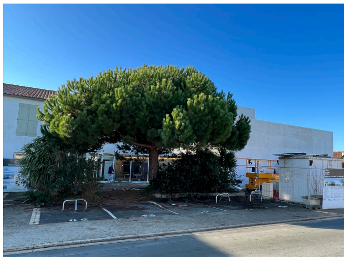
futur parvis d'accueil de La Maline
